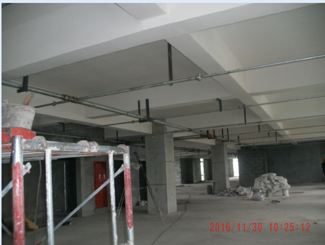
1#楼室内消防管安装11层-17层已安装
