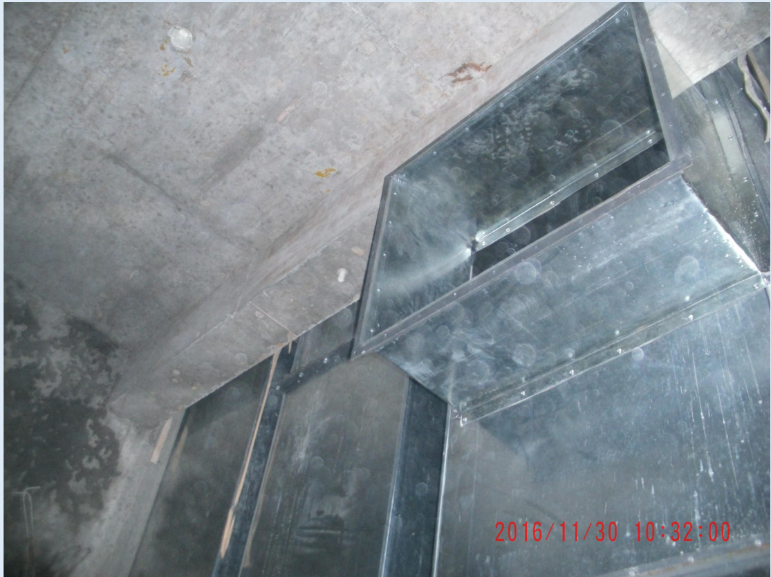
1#楼竖向通风管道已安装
