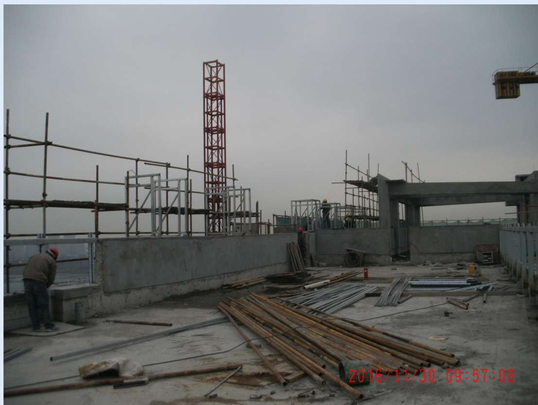
1#楼幕墙、外墙造型柱框架已安装至楼顶
