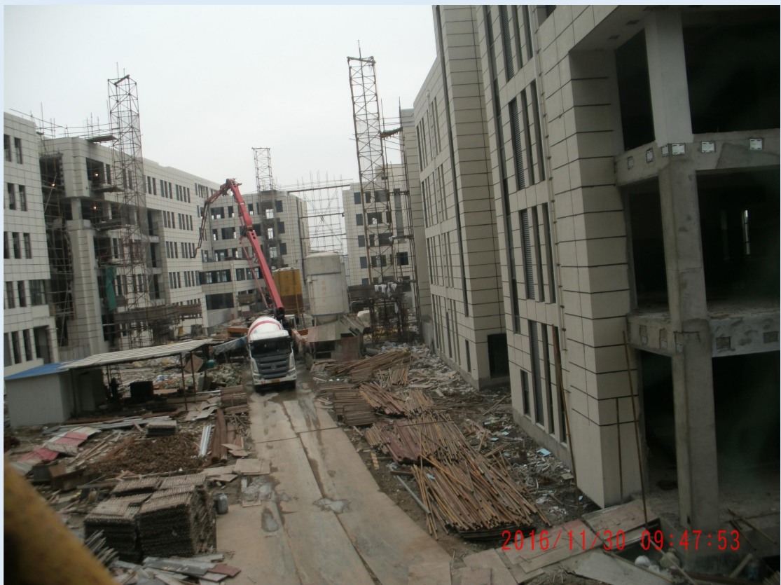
2-7#楼外架拆除，内外粉刷已完成，正在浇筑室内地坪
