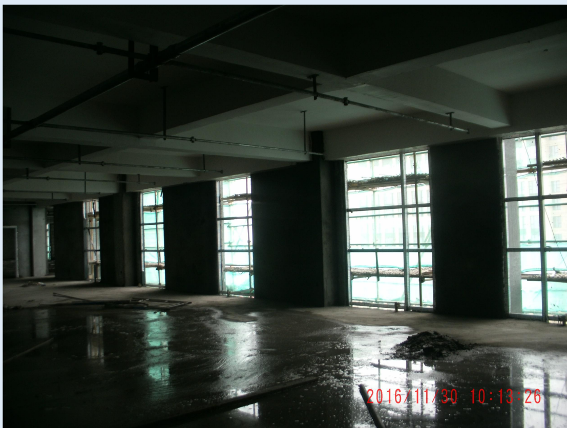
1#楼室内粉刷11层以上基本完成
