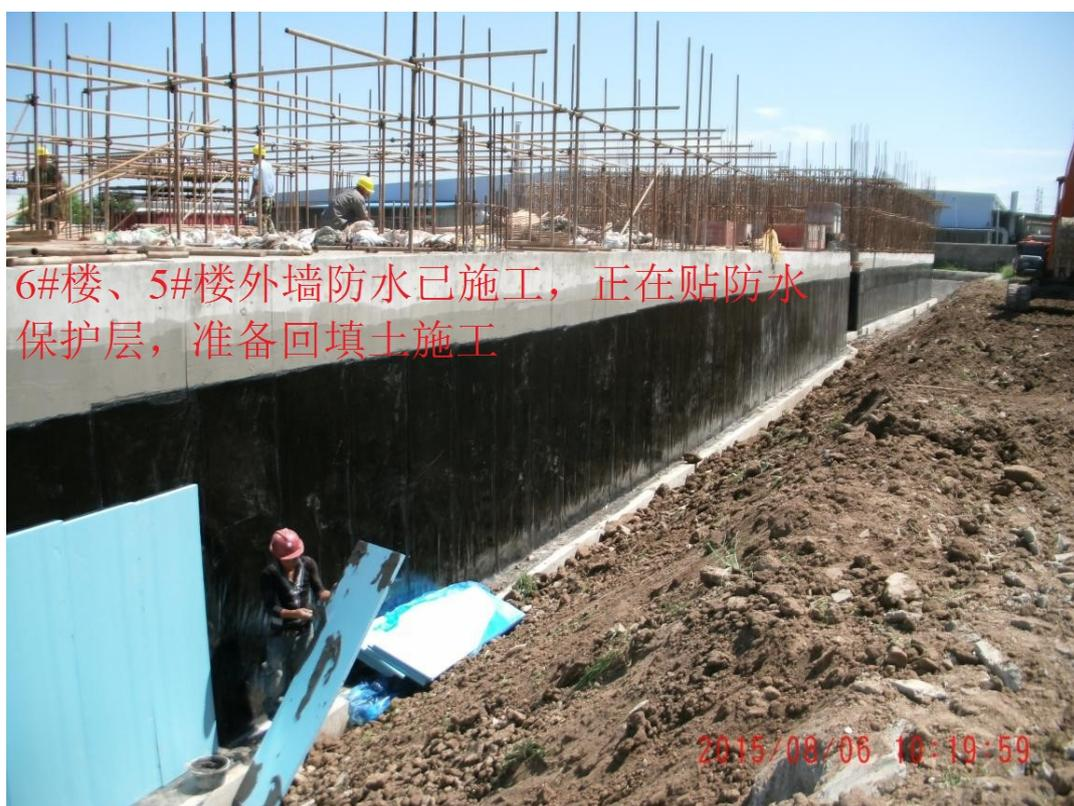
6#楼、5#楼外墙防水已施工，正在贴防水保护层，准备回填土施工
